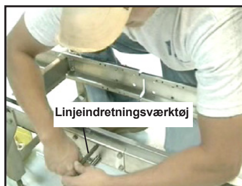
Figur 6: Brug linjeindretningsværktøjet (i det åbne hul) til at trække grundsektionerne sammen
